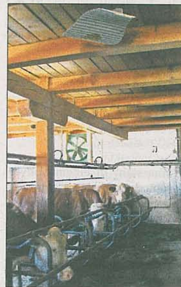
Die GeoWave®-Welle im Stallgebäude eines Landwirtes in Draßnitzdorf/Gailtal.
